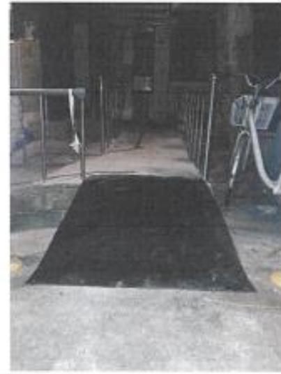
申請人為電動輪椅使用者，其家中舊有對外斜坡通道因離馬路距離過短，導致坡度甚陡，發生過數次受傷，經北投社工轉介尋求幫助，期盼能解決多年無法改善之問題。工作人員與該社區管委會多次現場協商會勘，取得管委會正式發文通知，增設一斜坡通道直接跨越水溝與馬路銜接，舊有通道以混凝土順平打磨粗面防止打滑，跨越排水溝斜坡，底部使用不鏽鋼花紋板成型加工後，使用螺絲固定，預防以後若有拆卸需求使用，最上層再鋪設止滑橡膠墊，與道路相鄰處，增設反光防撞桿警示，保障用路人安全。
